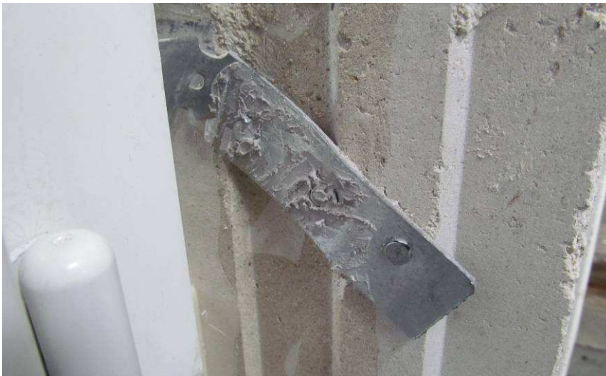
Bild 19 Zustand der Nagelung nach der Bauteilprüfung.
